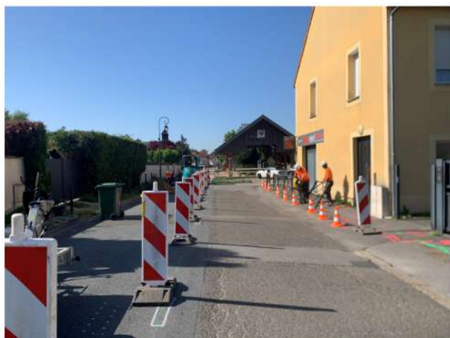
Réfection de l'arrivée vers la halle : 1ère étape
