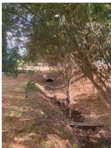
Mais il reste à le creuser et à déboucher la canalisation
