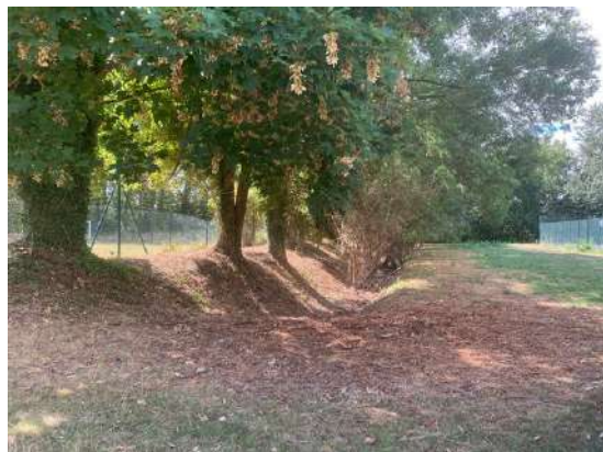
Dégagement total sur 8 mètres de large du fossé d'évacuation de nos eaux pluviales
