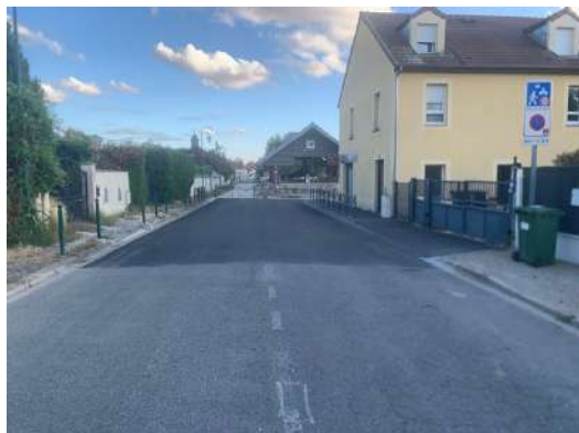
La réfection totale de l'arrivée de la rue Jean Jaurès sur la halle
