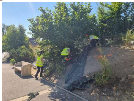
Les pourtours plastiques de la cour de l'école Le Petit Prince étaient en lambeaux : nous les avons tous enlevés
